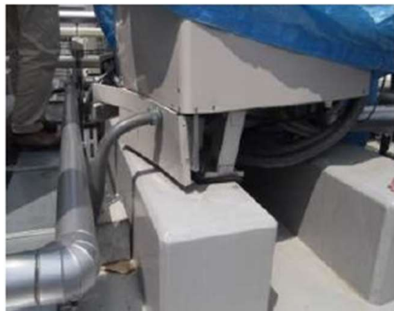
脚部損傷の例
