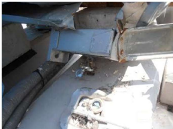
脚部損傷の例
