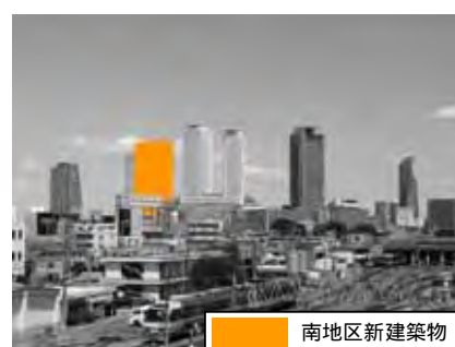
写真 2-5-12 №11 地点（黄金橋、撮影日：平成 21 年 8 月 24 日）
