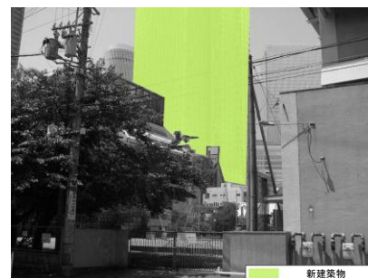
写真 3.1-6 No.6 地点（旧新明小学校前、撮影日：平成 29 年 6 月 13 日）
