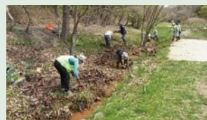
落ち葉の浚渫作業
