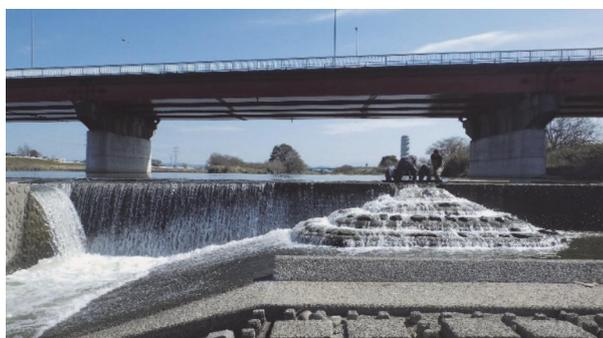
図2. 小田井堰堤左岸の扇形魚道とその周辺の遠景.
