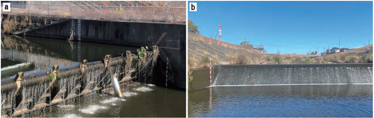
図2. 内津川本流の最下流に位置する可動堰（a）と放水路の最下流に位置する落差工（b）. ポールの長さは約2m.
