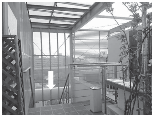
図6. 侵入経路と考えられる屋上階段の通行口.
