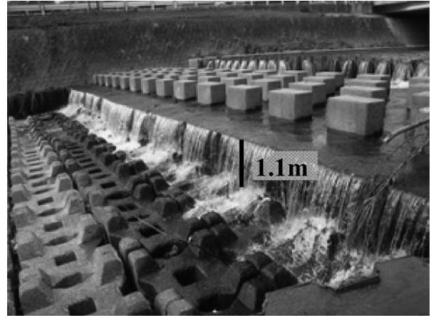
図5. 落差工Bの下流側の形状
