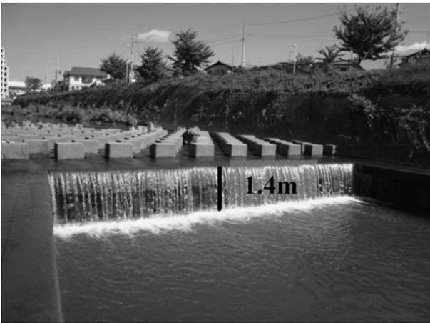
図2. 落差工Aの形状
