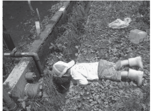
図3. 水田を囲うコンクリートの三面張り水路.
