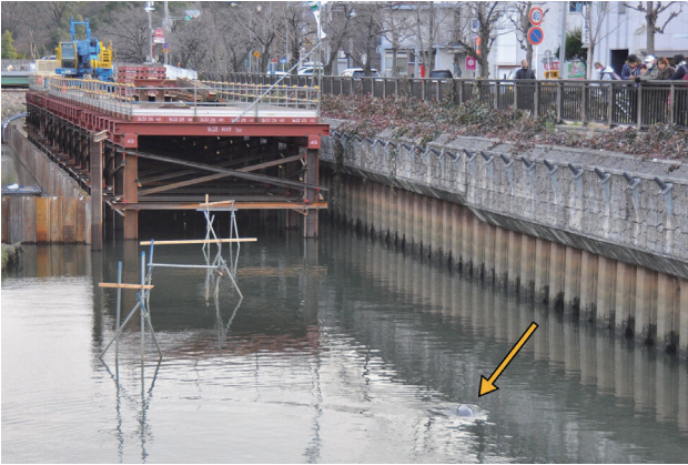
図5 2011年1月29日に堀川で観察されたスナメリ。写真奥が下流側で河川工事を行っている。
