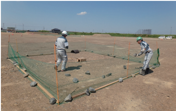
写真6 営巣箇所に保護ネット設置
