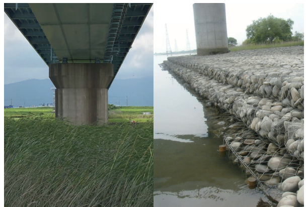
写真5 左：復元されたヨシ原，右：玉石護岸設置
