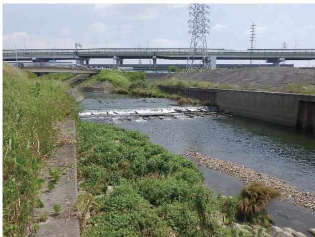
図3. St.2と落差工1の下げ潮時の状況.
