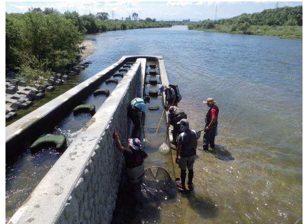
図3. 左岸側のアイスハーバー型階段式魚道
