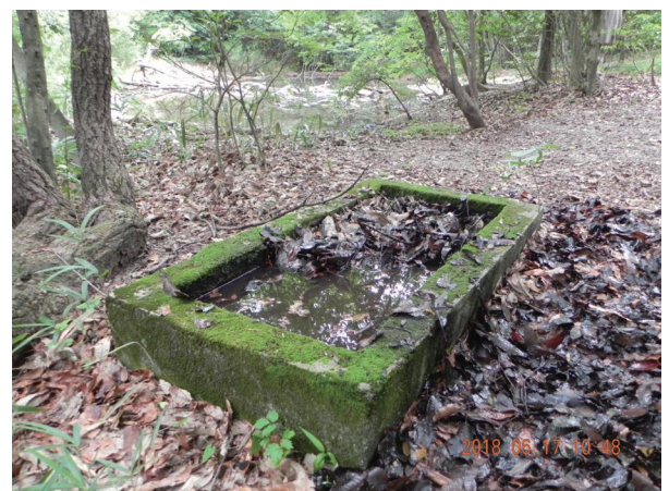
図14. 上端 沢止め池と防火貯水槽
