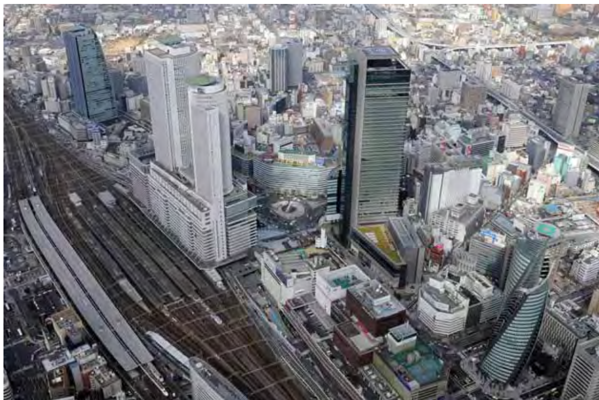
写真 2.5-1 事業予定地及びその周辺の状況（撮影日：平成 21 年 2 月）
