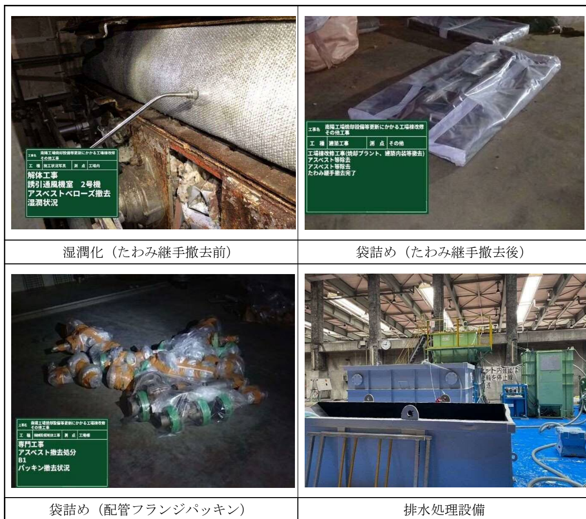
図 3-1-1 石綿飛散防止措置状況
