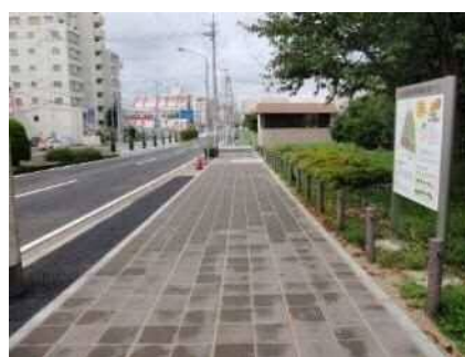
B 保水性ブロック舗装
