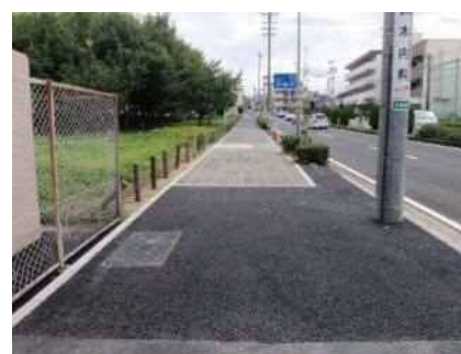
C 透水性アスファルト舗装
