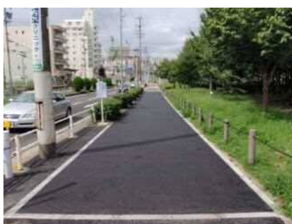
A 保水性アスファルト舗装
