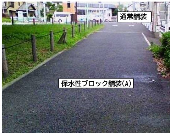
保水性アスファルト舗装 (A) の写真 (左) とサーモカメラ画像 (右) 撮影日：7月11日 (送水時間：40min/h)
