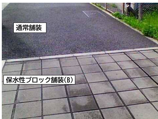
保水性ブロック舗装 (B) の写真 (左) とサーモカメラ画像 (右) 撮影日：8月29日 (送水時間：6min/h)
