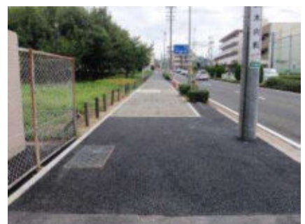
C 透水性アスファルト舗装
