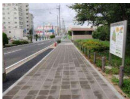
B 保水性ブロック舗装
