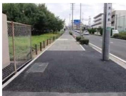
C 透水性アスファルト舗装
