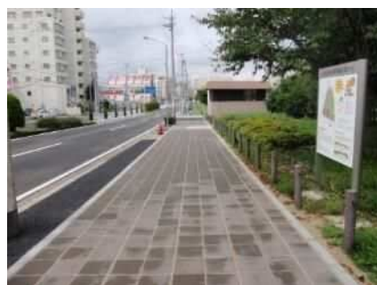
B 保水性ブロック舗装
