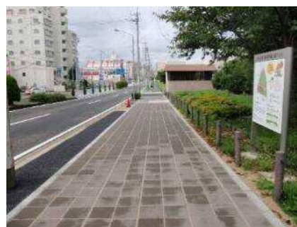
B 保水性ブロック舗装
