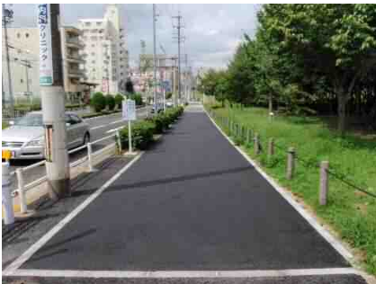
A 保水性アスファルト舗装
