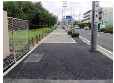
C 透水性アスファルト舗装
