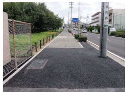
C 透水性アスファルト舗装
