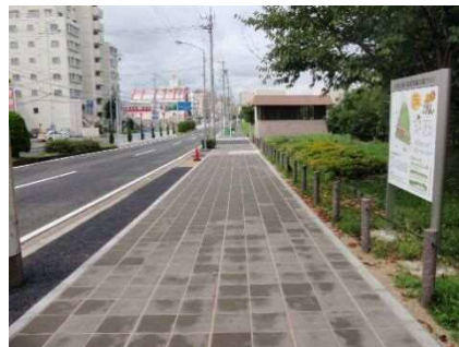
B 保水性ブロック舗装
