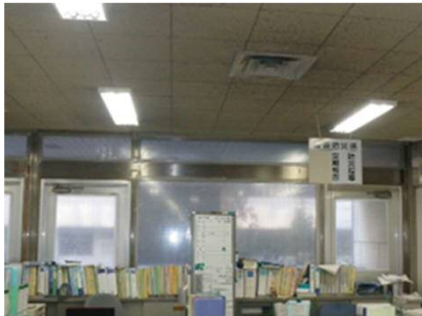
写真1 梱包材を貼った窓 （住宅都市局） 外気遮断による空調用エネルギー低減
