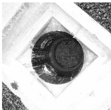
図3 浸透ます（底面から浸透する例）
