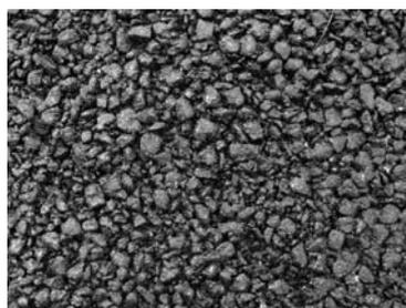
図1 アスファルト舗装（透水性舗装）
