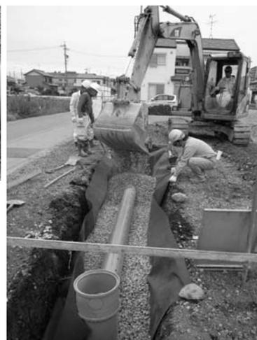
図6 浸透トレンチ施工状況
