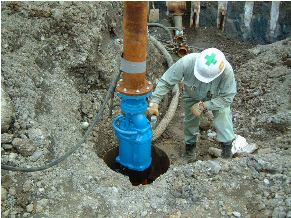
(ディープウェル鋼管（口径 600mm）の中に水中ポンプを建込んでいるところです。)
