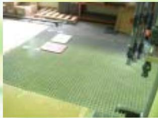
26 土壌汚染対策です。下にFRP<sup>1</sup>が施してあり、36000Lのピットが掘ってあります。地震等で、もし液が漏れてもピットに入ります。常時はクロム、ニッケルの廃液が入っていますのでポンプアップして排水処理設備へいきます。
