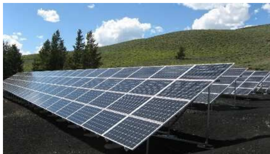
ご利用例：太陽光発電設備の設置
