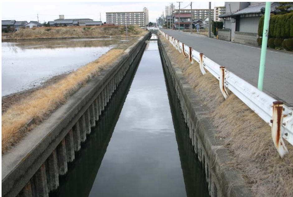
図9.1.11- 1 事業実施区域内にある水路の状況
