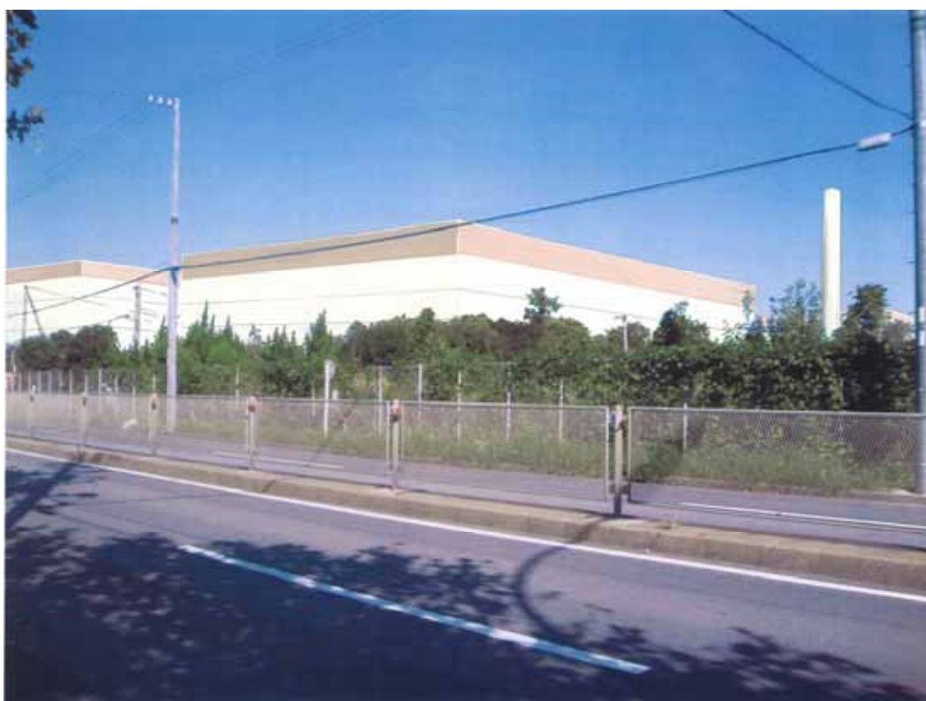
図 7-12-5(2) D 地点 (本施設全体供用時: (注) 合成した施設はイメージ図である)
