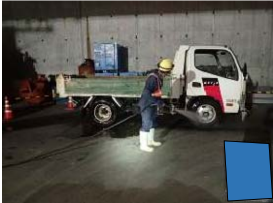
写真 6-1-2-7 資材及び機械の運搬に用いる車両の出入口、周辺道路の清掃及び散水、タイヤの洗浄
