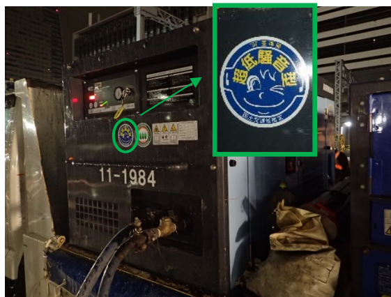
写真 6-1-2-4 低騒音型建設機械の採用
