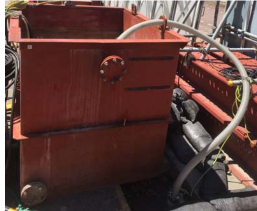
写真 6-1-2-8 工事排水の適切な処理
