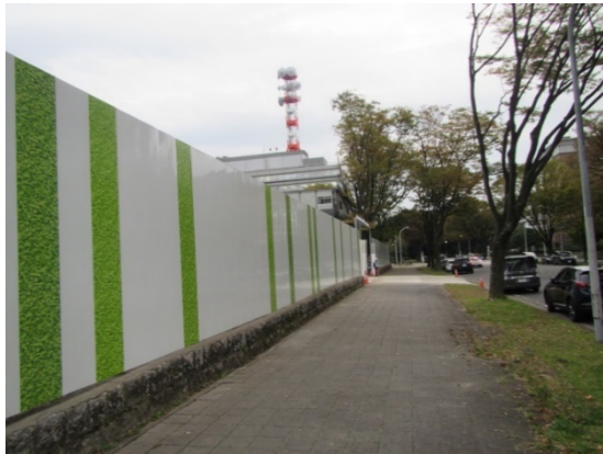
写真 6-1-1-1 仮囲い等の設置
