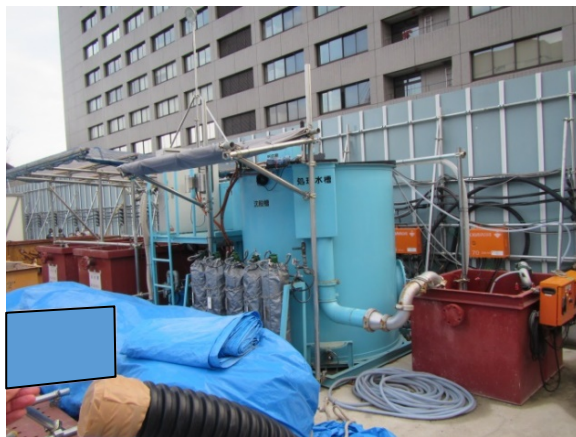
写真 6-1-1-8 工事排水の適切な処理
