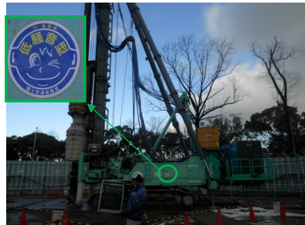
写真 6-1-1-4 低騒音型建設機械の採用
