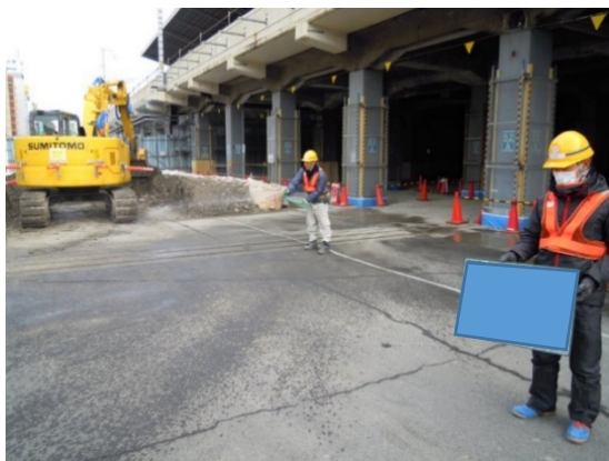
写真 6-1-2-5 工事現場の清掃、散水
