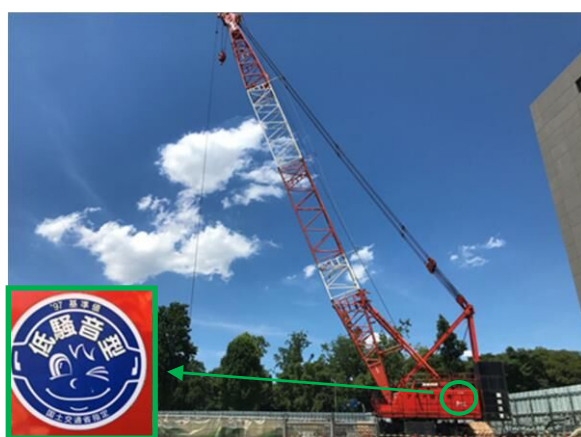
写真7-1-1-4 低騒音型建設機械の採用
