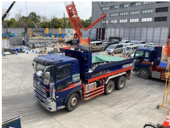
写真7-1-2-5 荷台への防塵シート敷設及び散水
