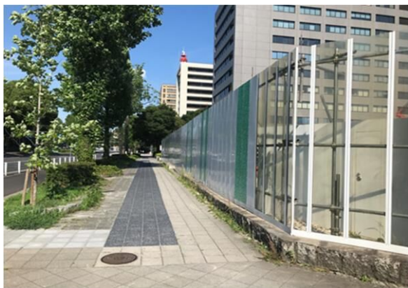
写真7-1-1-1 仮囲い等の設置状況
