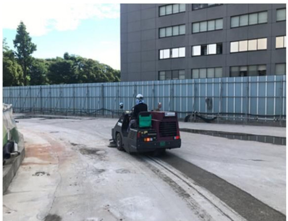
写真7-1-1-5 工事現場の清掃、散水
