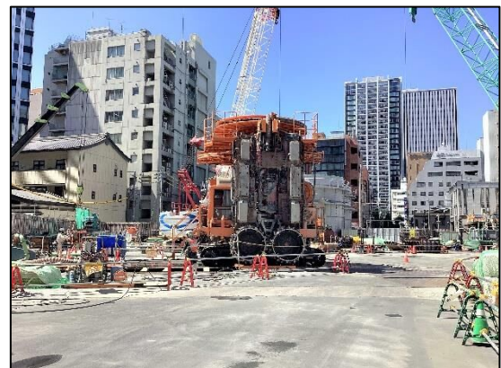
写真 3-2-3-1 (6) 名古屋駅（東工区）
