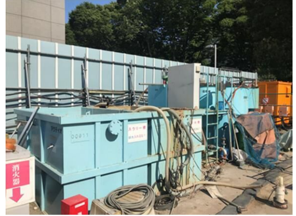
写真7-1-1-8 工事排水の適切な処理
