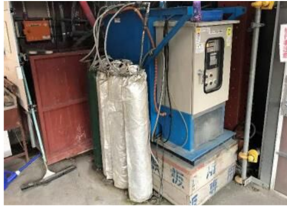
写真7-1-3-8 工事排水の適切な処理
