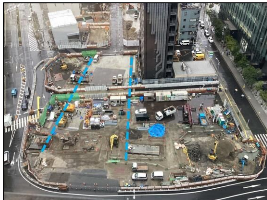
写真 3-2-3-1 (7) 名古屋駅（東山線工区）
