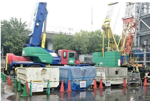
写真7-1-3-11 副産物の分別、再資源化
