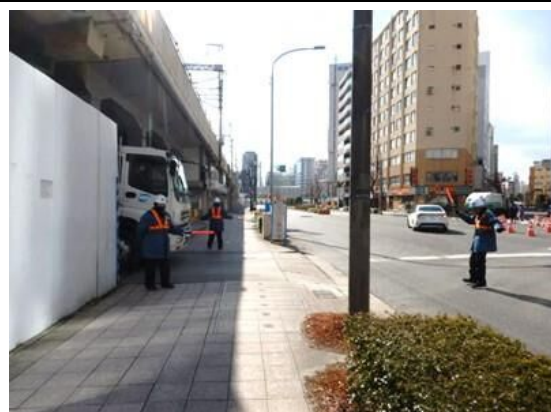
写真 7-1-4-12 交通誘導員による誘導
