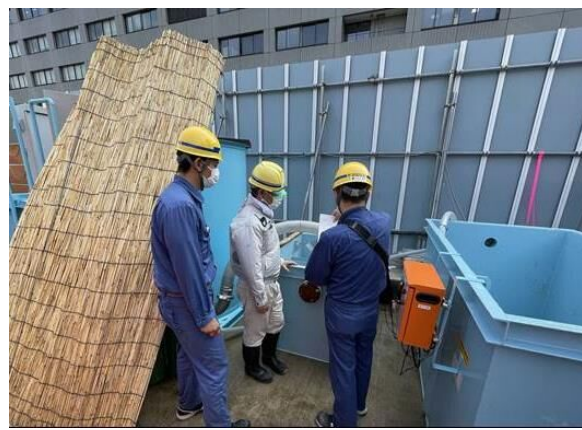
写真7-1-2-6 工事排水の適切な処理
