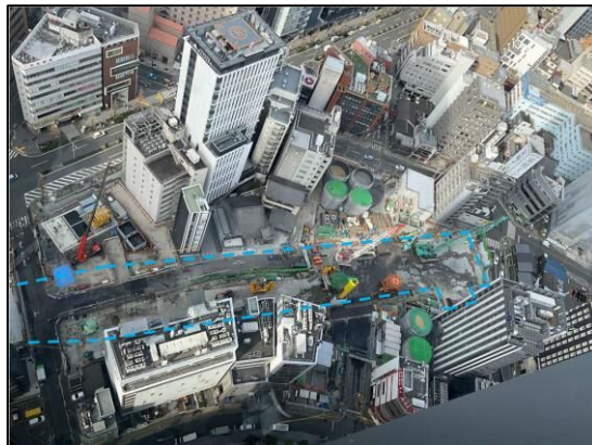
写真 3-2-3-1 (5) 名古屋駅（東工区）
