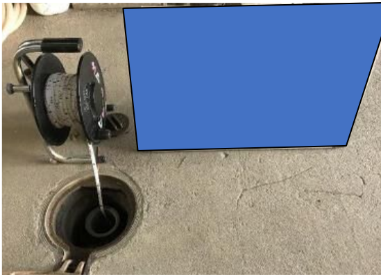
写真7-1-3-9 地下水の継続的な監視
