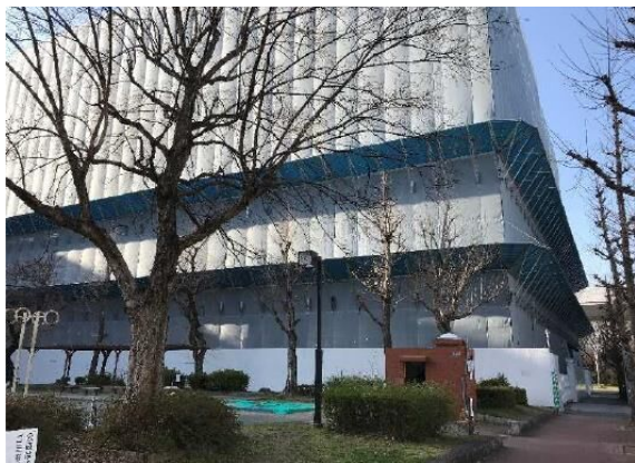
写真7-1-3-1 仮囲い等の設置状況
