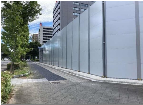
写真7-1-2-1 仮囲い等の設置状況
