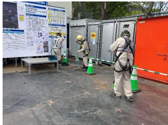
写真7-1-2-4 工事現場の清掃及び散水
