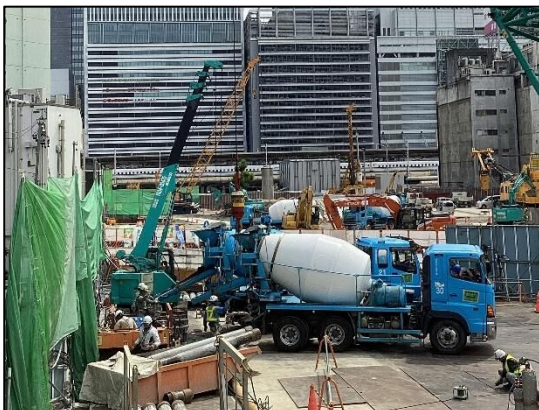
写真 3-2-3-1(14) 名古屋駅（西工区）
