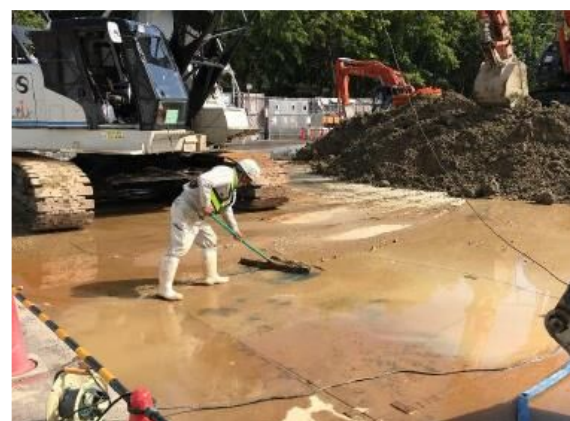
写真7-1-3-5 工事現場の清掃、散水
