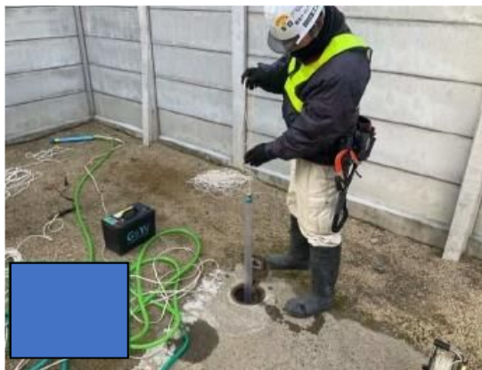
写真 7-1-4-9 地下水の継続的な監視
