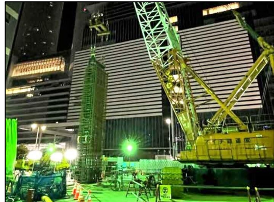
写真 3-2-3-1 (8) 名古屋駅（東山線工区）
