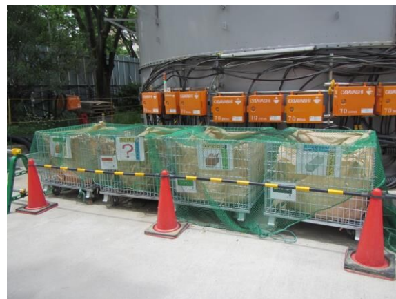
写真7-1-1-11 副産物の分別、再資源化
