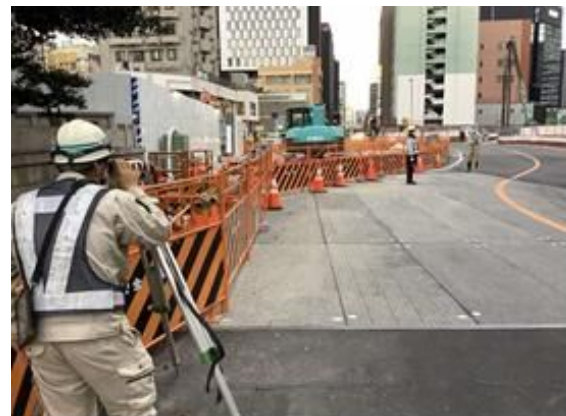
写真 7-1-4-10 山留め材及び周辺地盤の計測管理
