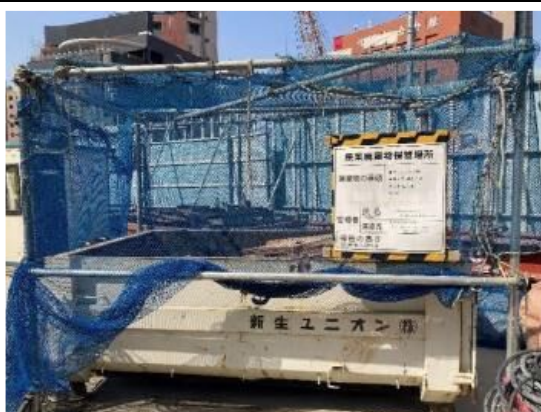
写真 7-1-4-11 副産物の分別、再資源化
