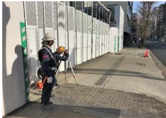
写真7-1-3-10 山留め材及び周辺地盤の計測管理
