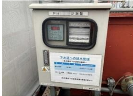
写真 7-1-4-8 工事排水の適切な処理
