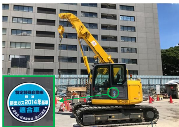
写真7-1-1-2 排出ガス対策型建設機械の採用
