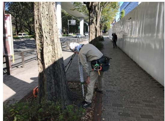
写真7-1-2-10 山留め材及び周辺地盤の計測管理
