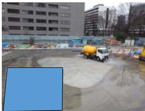
写真7-1-1-6 工事現場の清掃、散水
