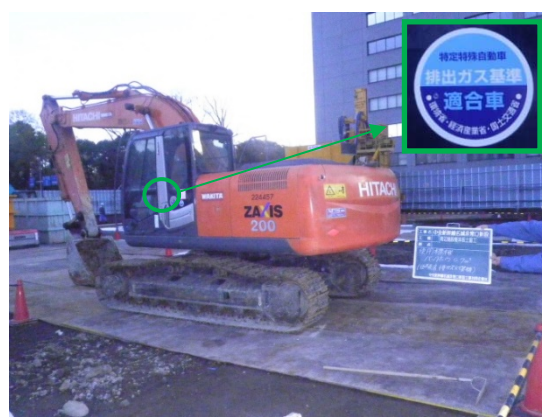
写真7-1-1-2 排出ガス対策型建設機械の採用
