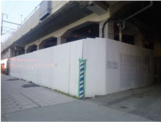
写真 7-1-3-1 仮囲い等の設置
