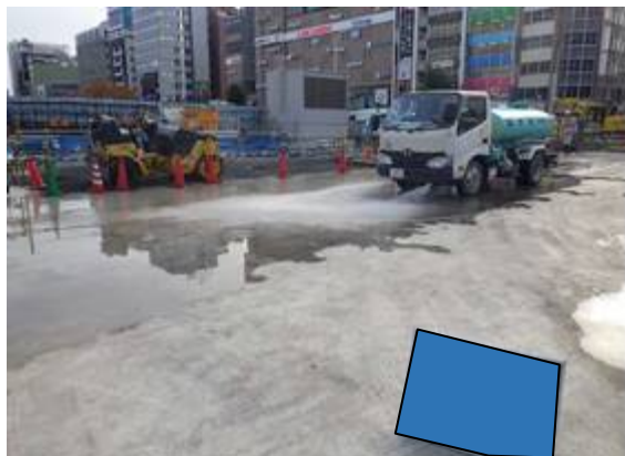
写真 7-1-3-5 工事現場の清掃、散水
