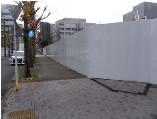
写真7-1-2-1 仮囲い等の設置
