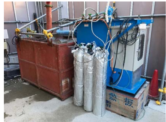
写真7-1-2-8 工事排水の適切な処理
