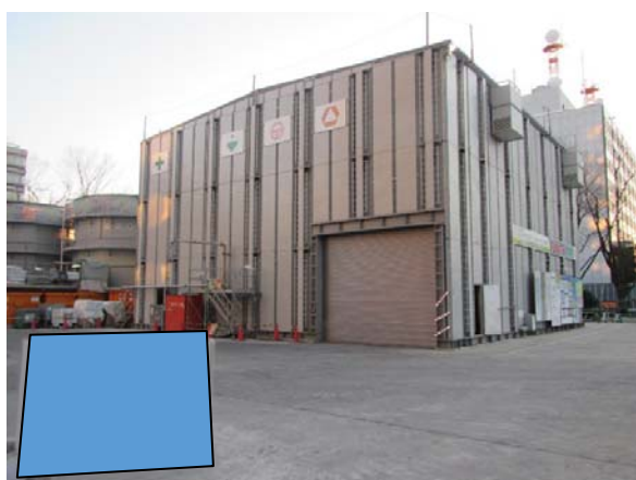
写真7-1-1-5 防音ハウスの設置
