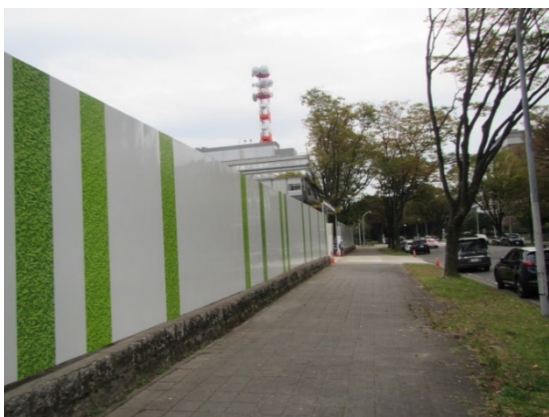
写真7-1-1-1 仮囲い等の設置
