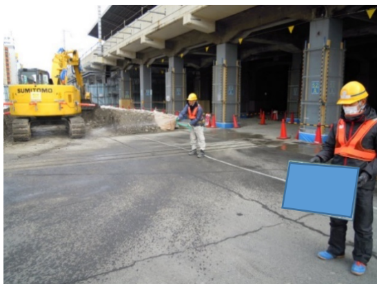
写真 6-1-2-5 工事現場の清掃、散水
