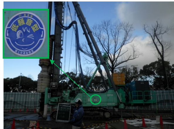
写真 6-1-1-4 低騒音型建設機械の採用
