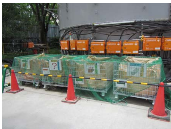
写真 6-1-1-11 副産物の分別、再資源化
