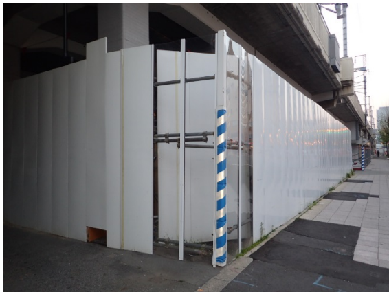
写真 6-1-2-1 仮囲い等の設置
