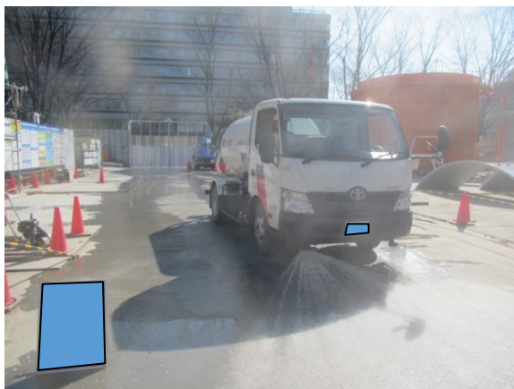
写真 6-1-1-5 工事現場の清掃、散水
