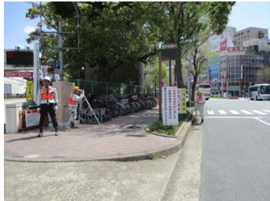
写真 6-1-2-10 山留め材及び周辺地盤の計測管理
