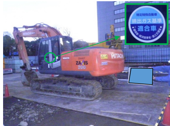
写真 6-1-1-2 排出ガス対策型建設機械の採用
