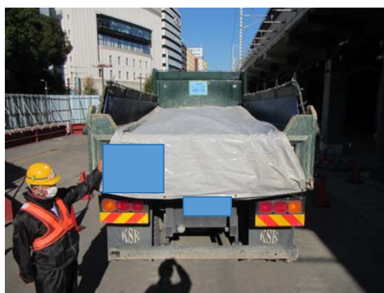
写真 6-1-2-6 荷台への防じんシート敷設及び散水
