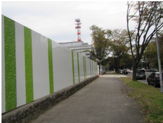
写真 6-1-1-1 仮囲い等の設置
