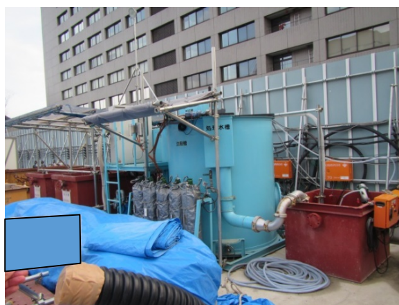
写真 6-1-1-8 工事排水の適切な処理
