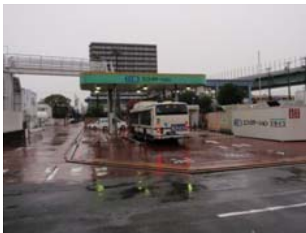
写真2-13-1 事業予定地内に設置されているCNGステーション
