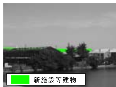
写真 2-8-4 No.3 地点（1 期工事完了後）[東海橋、撮影日：平成 25 年 7 月 10 日]
