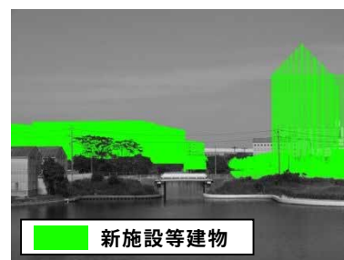
写真 2-8-8 No.5 地点（1 期工事完了後）[本宮橋、撮影日：平成 25 年 7 月 10 日]
