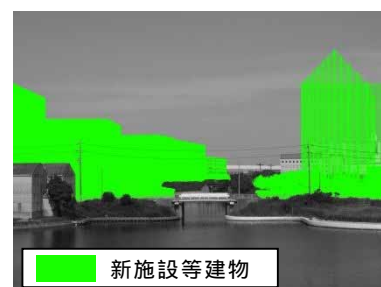
写真 2-8-9 No.5 地点（2 期工事完了後）[本宮橋、撮影日：平成 25 年 7 月 10 日]
