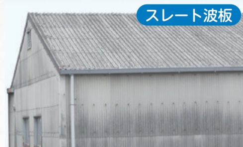
図1 アスベストを使用している建築材料 (国土交通省「目で見えるアスベスト建材」より)
