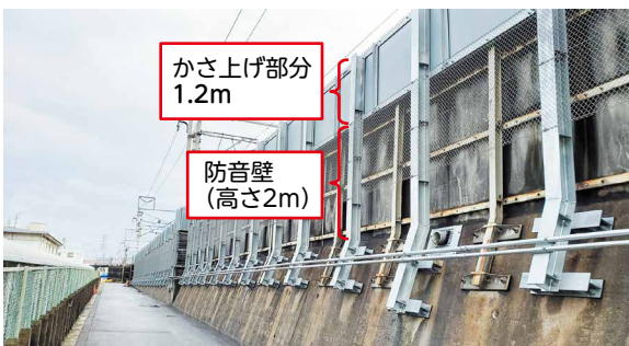
図3 防音壁かさ上げ
