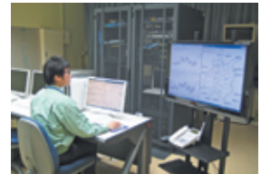
常時監視システムによる監視の様子
