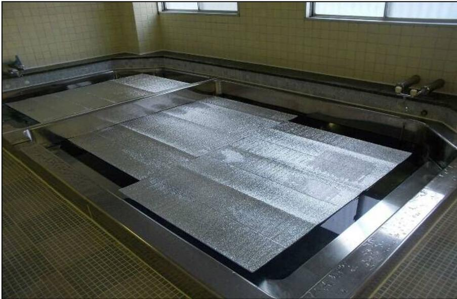
42℃の浴槽の表面からの蒸発熱損失は650W/m<sup>2</sup>程度と大きい
