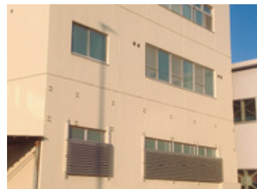
遮熱防水塗装した外壁
