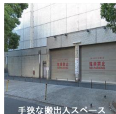
手狭な搬出入スペース
