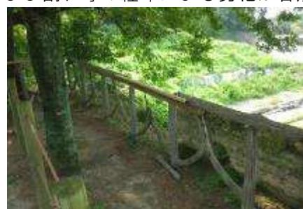
写真4-70 擬木柵の欠損部
