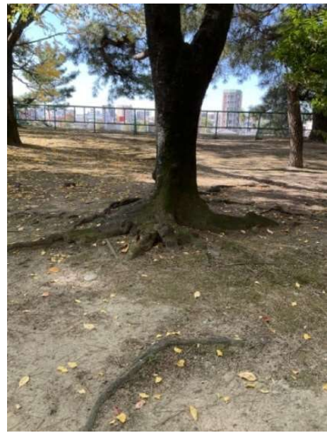
写真 3-3-6 【御深井丸】園路及び園路近傍に 不陸を生じさせている樹木
