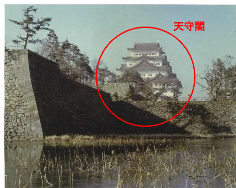
写真 3-8-6 水堀北東側から天守閣への見通し (昭和 35 年 (1960) 頃撮影) 『名古屋城総合事務所蔵』 (状況) 天守閣の大部分が認識できる。
