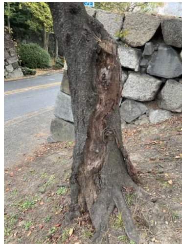
写真 3-3-2 【外堀 (空堀)】枯損木・半枯れ木 幹の腐朽
