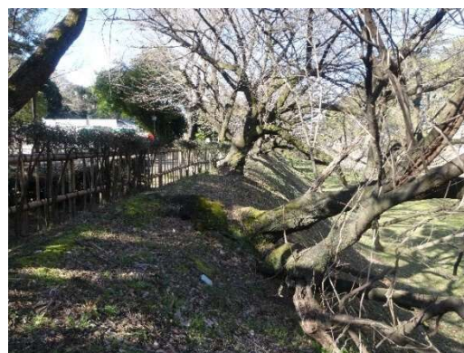
写真 3-2-2 【外堀(空堀)】二之丸大手門付近の状況
