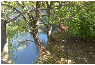
写真 4-33 石垣の保存に影響を与える樹木 (月見櫓跡東石垣上)
