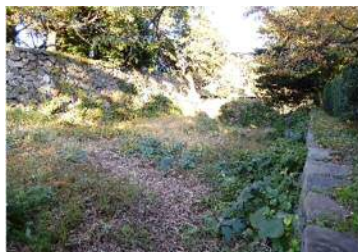
写真 4-12 空堀に繁茂している草本類 （搦手馬出南）
