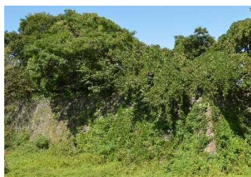
写真 4-30 石垣を被覆する草本類 (南側石垣)
