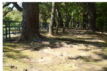
写真 4-17 根上りしているクロマツ （大手馬出跡南側土塁上）
