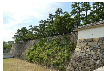
写真 4-11 石垣を被覆している草本類 （大手馬出東側）
