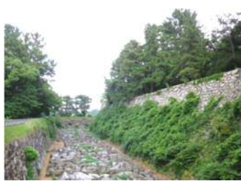
写真 4-10 石垣を被覆している草本類 （不明門より東側内堀）
