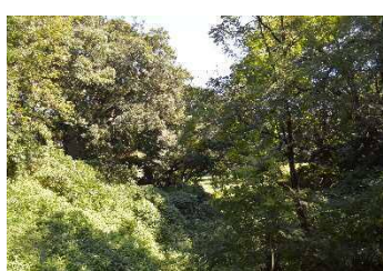
写真 4-61 土塁・堀に繁茂した樹木・草本類 (本町橋東)
