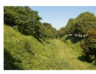
写真 4-62 土塁・堀に繁茂した草本類 (東門跡北)
