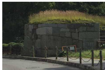
写真 4-72 狭小な歩道 (二之丸東門枳形付近)
