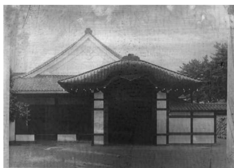
写真 3-15 本丸御殿 （玄関・車寄外観）
