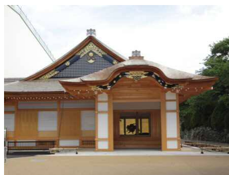
写真 3-16 本丸御殿 （玄関・車寄外観）（現在）
