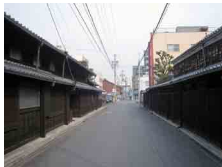
大船町通沿いの土蔵、町家
