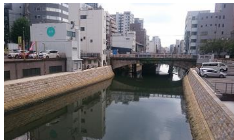
伝馬橋上流の護岸工事 （上：整備前 下：整備後）
