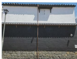
レストラン土蔵修理（漆喰塗替え等） （左：修理前 右：修理後）
