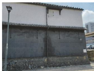
レストラン土蔵修理（漆喰塗替え等） （左：修理前 右：修理後）
