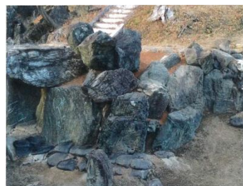
石組修復後（二之丸庭園北園池）
