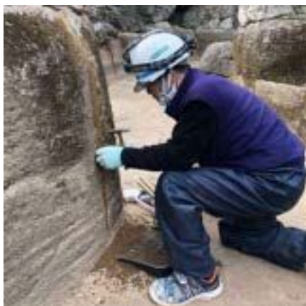
護岸ひび割れ修理
