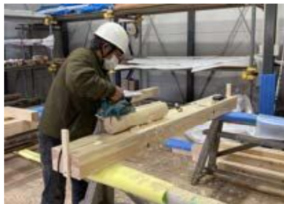
余芳部材修理
